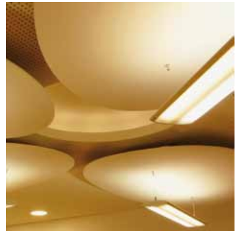
Beleuchtung mit Tageslichtnachführung: Abendstimmung durch gedimmtes, warmes Licht
